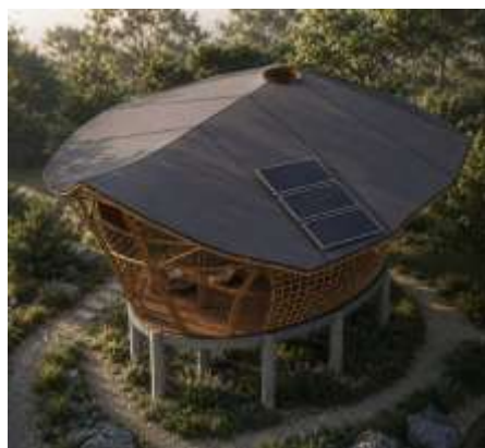
Gambar 12. Pemanfaat Solar Panel Pada Cottage
