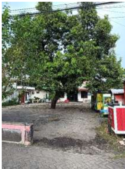
Gambar 1.5 Kondisi Area Parkir Stadion Ketonggo Ngawi
