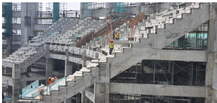
Gambar 13. Beton precast tribun
