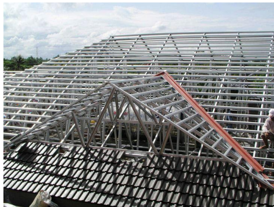
Gambar 4. 31 Struktur Atap Rangka Baja Genteng Tanah liat (Sumber: Pinterst)
