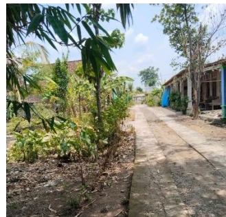
Gambar 31. Kondisi Jalan di Kedungsari Sumber : Dokumentasi Penulis, 2025
