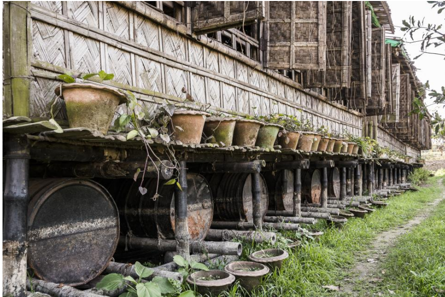
Gambar 2. 6. Struktur drum pada bangunan Sumber: Haque, S., 2016
