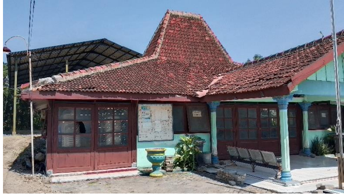
Gambar 4. Kondisi Eksisting Balai Desa Kuwaron (Sumber: dokumentasi pribadi, 2026)
