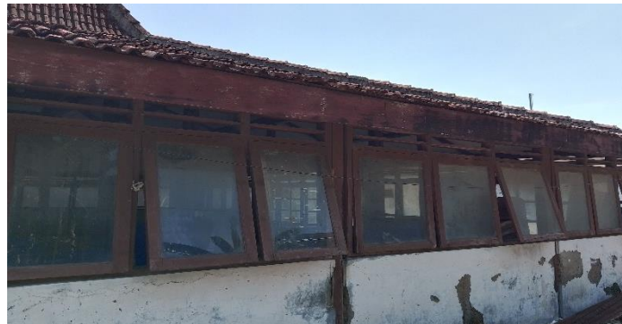
Gambar 5. Kondisi Eksisting Balai Desa Kuwaron (Sumber: dokumentasi pribadi, 2026)
