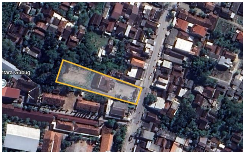
Gambar 25. Lokasi Balai Desa Kuwaron (Sumber: Google Earth, 2026)
