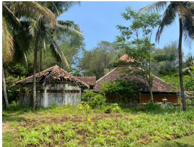
Gambar 3. 3 Kondisi Bangunan Akuarium Pantai Kukup
