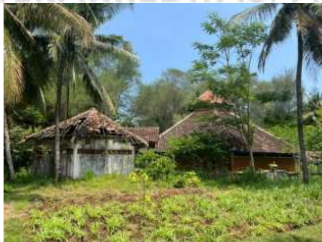
Gambar 5. Kondisi Bangunan Akuarium Pantai Kukup (Sumber: Dokumentasi Pribadi Penulis, 2026)
