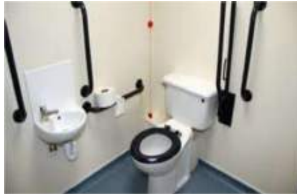
Gambar 11. Toilet Disabilitas (Sumber : PKMK UGM, 2013)
