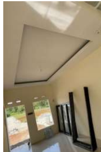
Gambar 7. Penggunaan material alumunium untuk kusen dan plafon gypsum (Sumber : Dokumentasi pribadi tanggal 17 April 2026)
