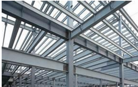
Gambar 19 Struktur Baja WF (Sumber: Google Images, 2025)
