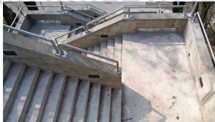
Gambar 3. 20 Tangga Beton Bertulang Sumber : primareadymix.co.id
