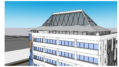
Gambar 27. Atap Limasan Joglo Sumber : Analisis Pribadi, 2026
