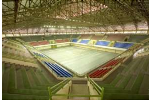
Gambar 2. 19 Struktur Bentang Lebar
