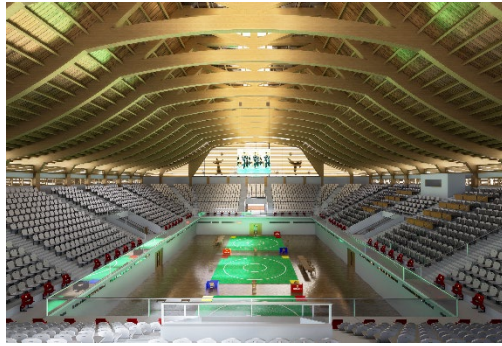
Gambar 28. Struktur Bentang Lebar Kayu Glulam Sumber : Analisis Penulis, 2026
