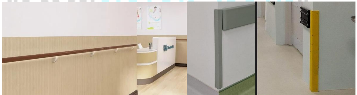
Gambar 13. Elemen Proteksi Bangunan: (a) Handrail pada Koridor dan (b) Wall Guard (Sumber: (a) jnhengsheng.en.made-in-china.com , 2020; (b) interdesign.co.id , 2020)
