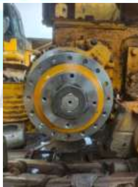
Gambar 9. Pemasangan Housing Hub dan Nut
