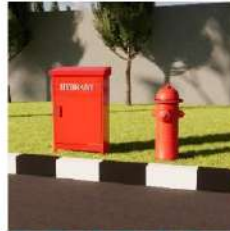
Gambar 13. Perangkat Proteksi Kebakaran Luar Ruang
