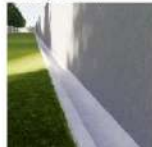
Penambahan selokan utara
