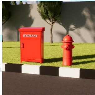
Gambar 13. Perangkat Proteksi Kebakaran Luar Ruang
