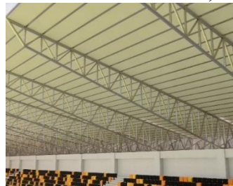
Gambar 24. Konsep Rangka Atap Pipa
