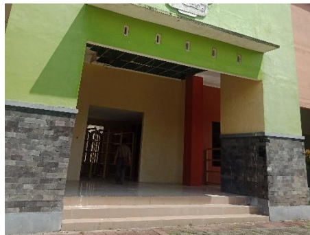
Gambar 94. Akses Masuk Bangunan
