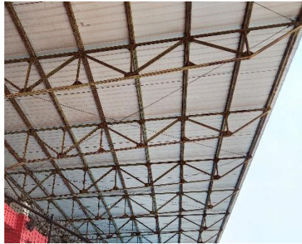
Gambar 126. Rangka Atap IWF
