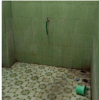
Gambar 96. Kondisi Toilet Difabel
