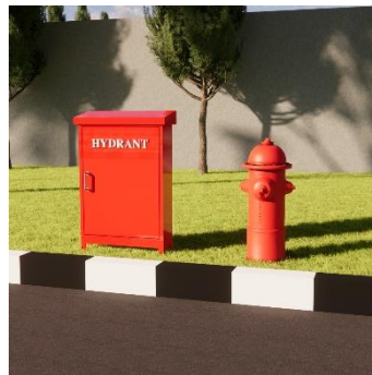
Gambar 110. Perangkat Proteksi Kebakaran Luar Ruang
