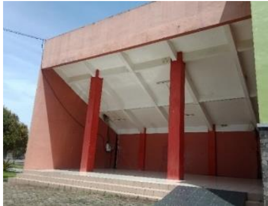
Gambar 86. Kondisi Eksisting Area Parkir Mobil Lantai 1 Tribun Timur
