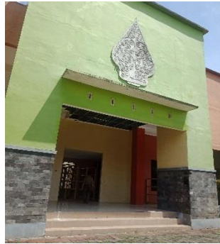
Gambar 141. Akses Masuk Bangunan
