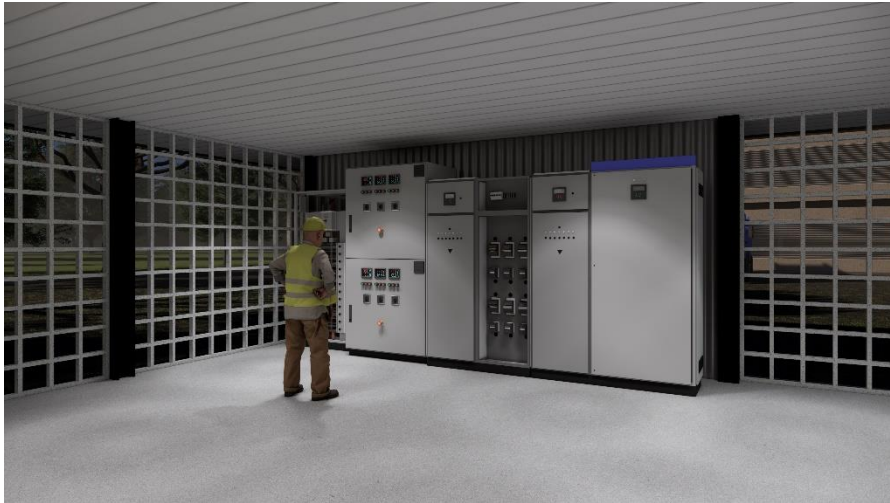
Gambar 10. Interior Power House Sumber: Dokumen Penulis (2025)
