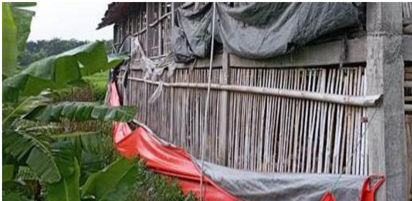
Gambar 17. Rongga Pada Panggung Kandang Ayam Mempengaruhi Sirkulasi Udara.
