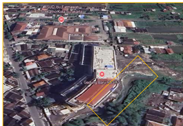
Gambar I Pengukuran Topografi dan Lokasi Pembangunan Dinding Penahan Tanah
