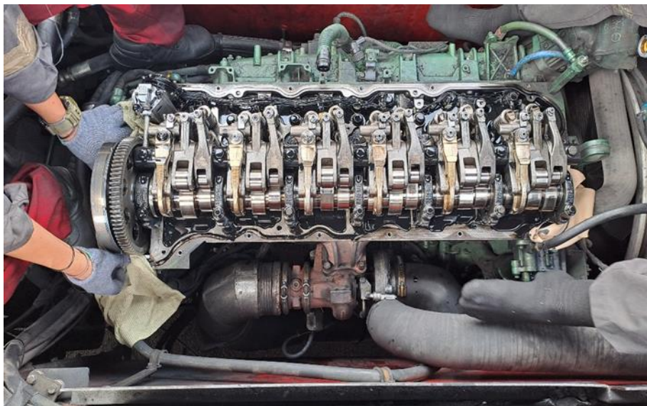
Gambar 3. 1.4 Pengecekan Exhaust Line
