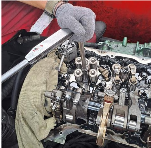
Gambar 3. 1.12 Memasang Injector pada Cylinder Head
