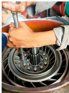
Gambar 14 Pemasangan Bolt Pump Impeller
