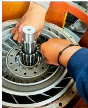
Gambar 13 pemasangan pump impeller
