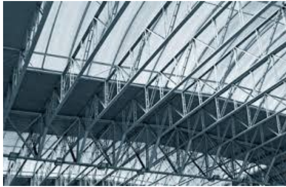
Gambar 21. Struktur Space Truss
