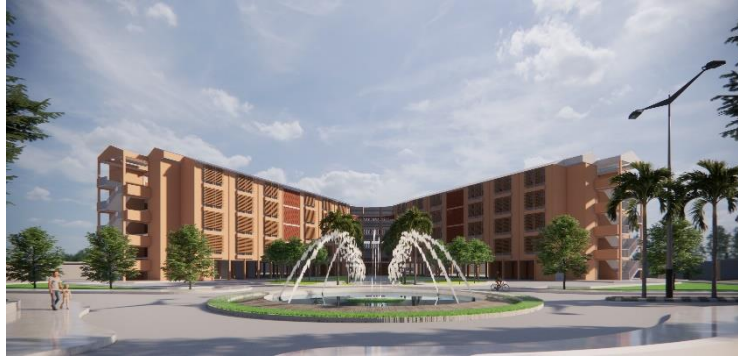
Gambar 15 Bangunan Tipe 21 Sumber: Dokumen Penulis
