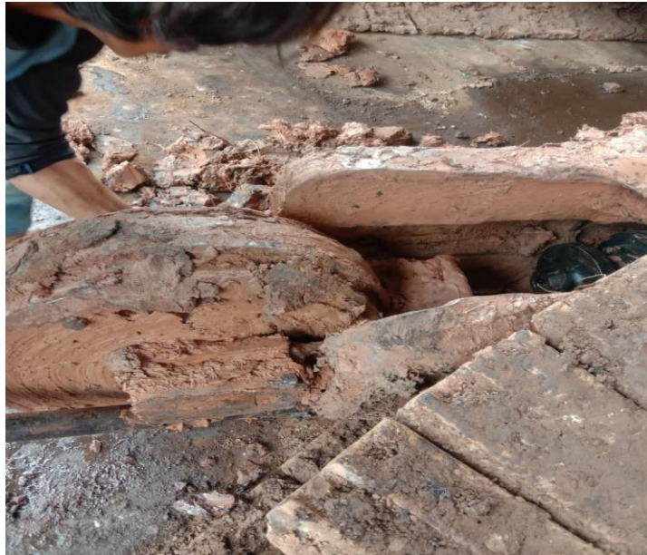
Gambar 13 Pemasangan Front Idler
