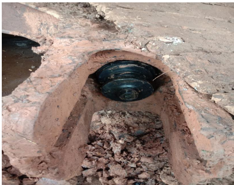
Gambar 12 Track Adjuster yang sudah terpasang
