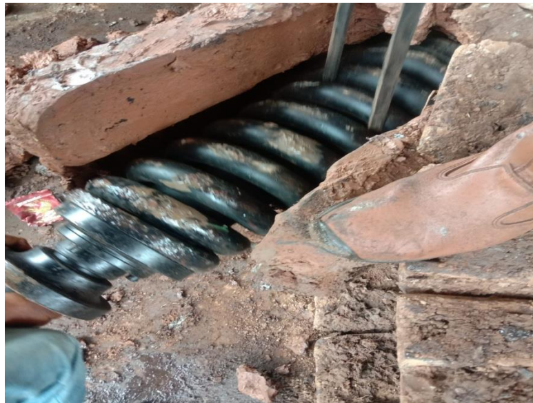
Gambar 11 Pemasangan Track adjuster
