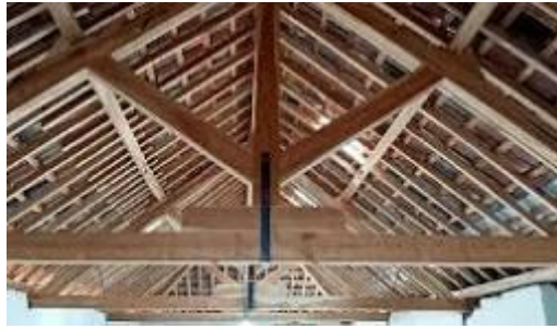
Gambar 10. Rangka Atap Kayu
