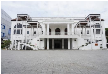
Gambar 4 Fasad Bangunan Taman Budaya Yogyakarta Sumber : (Google Inc : Taman Budaya Yogyakarta, 2023)
