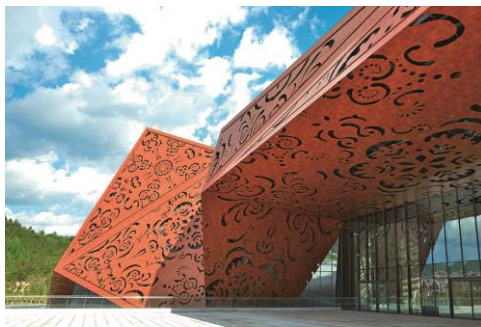
Gambar 10 Detail Bangunan TSCC
