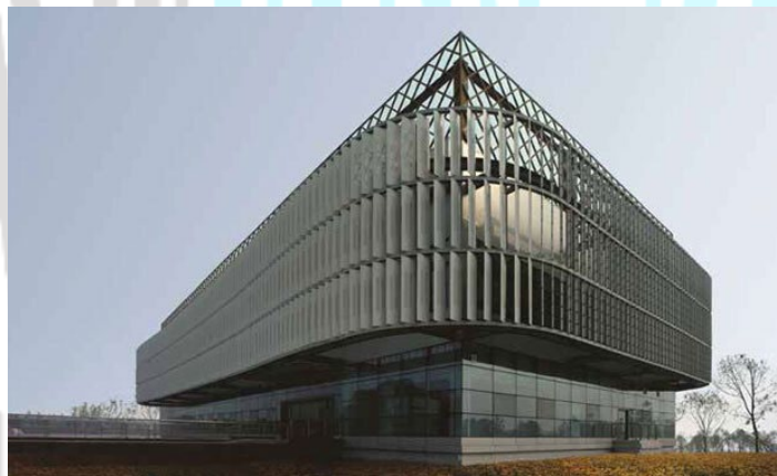
Gambar 27. Kisi-kisi pada Fasad Bangunan Streamline
