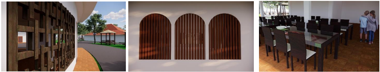
Gambar 24. Kayu limbah karet digunakan sebagai material bangunan
