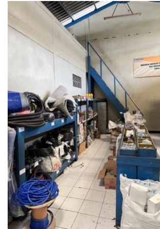
Gambar 8. Adanya Tumpukan Busa di Bagian Tempat Penyimpanan Kabel
