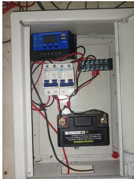
Gambar 6. Rangkaian Kelistrikan Box Panel
