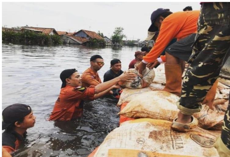
**Gambar 2.** Gotong Royong Perbaikan Kebocoran Tanggul Di Kota Pekalongan
