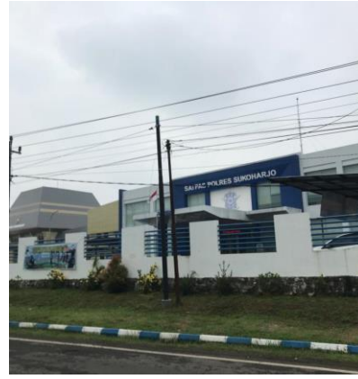
Gambar 2. Pembangunan Perkantoran Baru (Kantor Pemerintahan)
