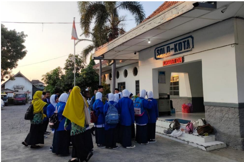
Gambar 1. 3 Kondisi Stasiun Solo Kota (Sumber: Dokumentasi Penulis, 2023)
