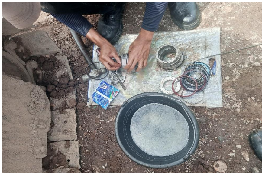
Gambar 3 Proses Pembersihan Komponen Lift Cylinder (Sumber : Workshop Daya Kharisma)
