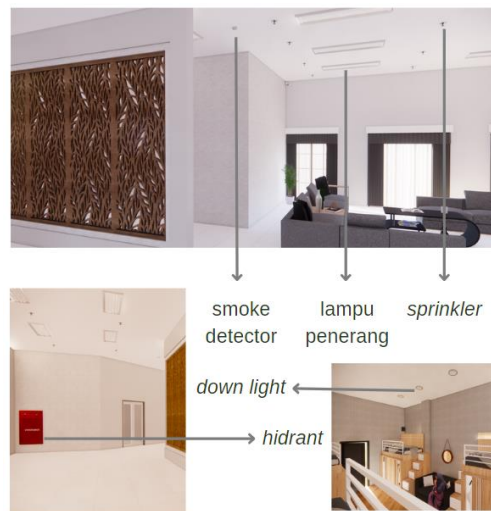
. Gambar 2 Penerapan Instalasi Listrik & Proteksi Kebakaran
