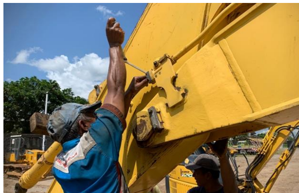
Gambar 6. Melepas selang pipa hidrolik
