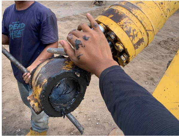
Gambar 5. Melepas baut pada cylinder bucket
