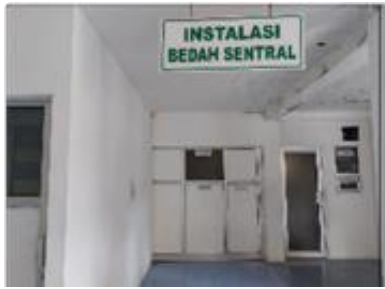
Gambar 2. Ruang IBS yang sudah tidak difungsikan
