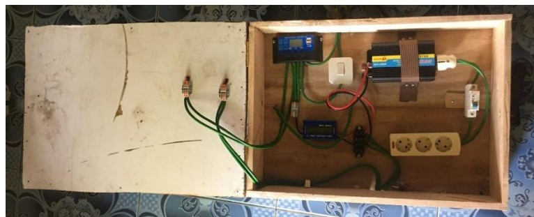
Gambar 3. Box Panel Rakitan dari Kayu
