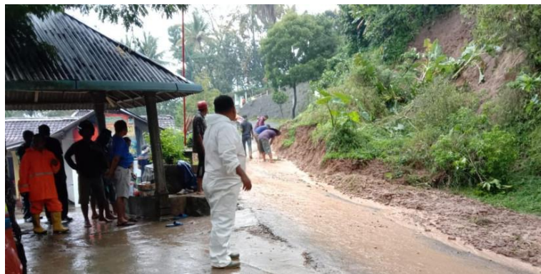
Gambar 1.1 Longsor di jalan utama menuju Telaga Ngebel Sumber: (BPBD Ponorogo, 2022)
