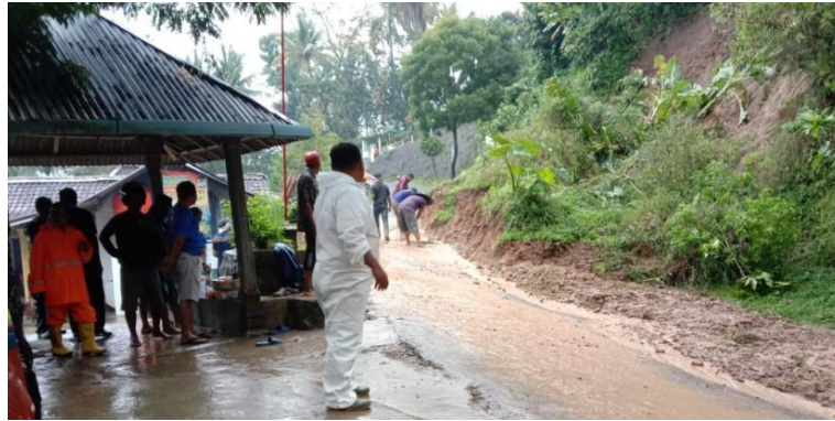
Gambar 1.1 Longsor di jalan utama menuju Telaga Ngebel
