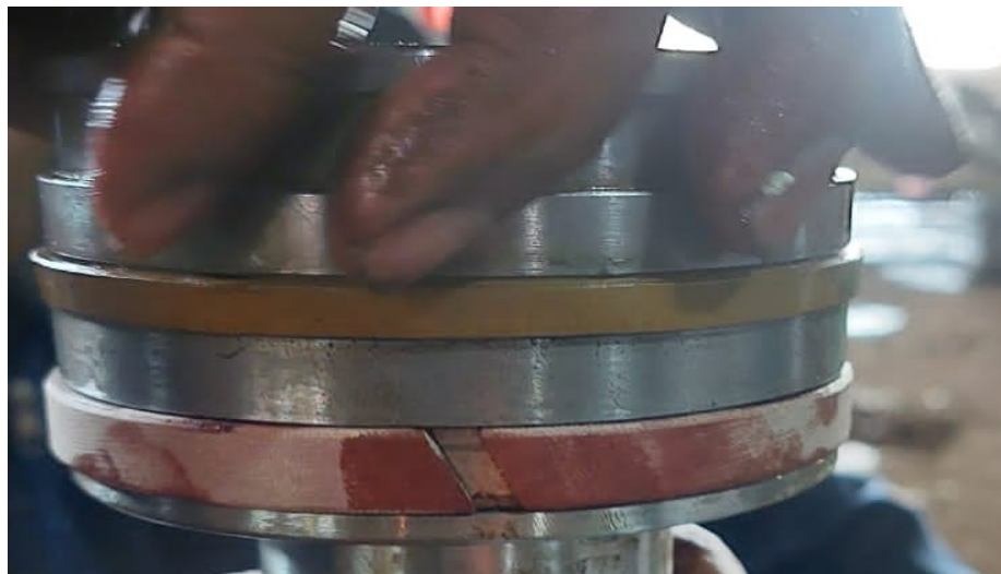
Gambar 6 Pemasangan Piston Pada Rod
