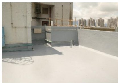
Gambar 11. Atap Dak Beton
