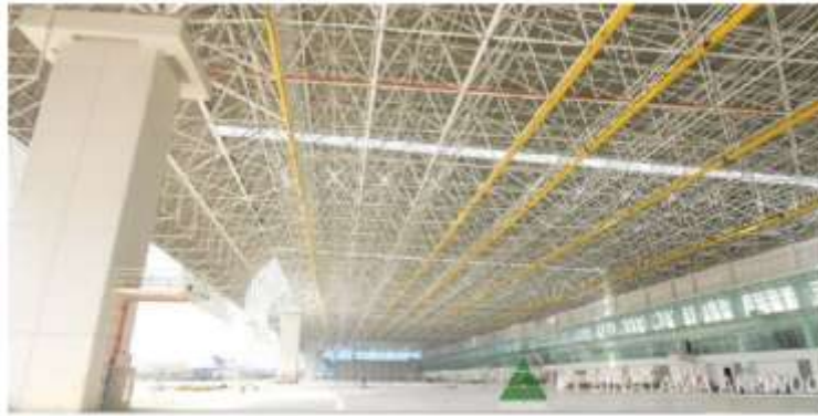
Gambar 15. Struktur Atap Space Frame (Sumber: http://www.tridome.co.id/ )
