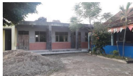
Gambar 2. Kondisi Eksisting madrasah (sumber: Dokumentasi Pribadi, 2020)
